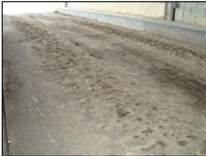
Figura 5.4. Romana utilizada para pesar maquinaria
