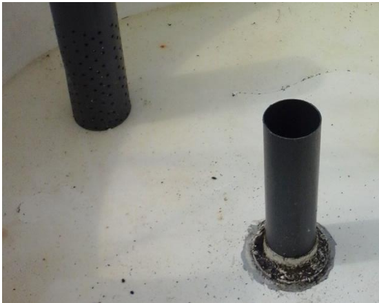
Figura 3-4. Tubería interna del tanque con peces
