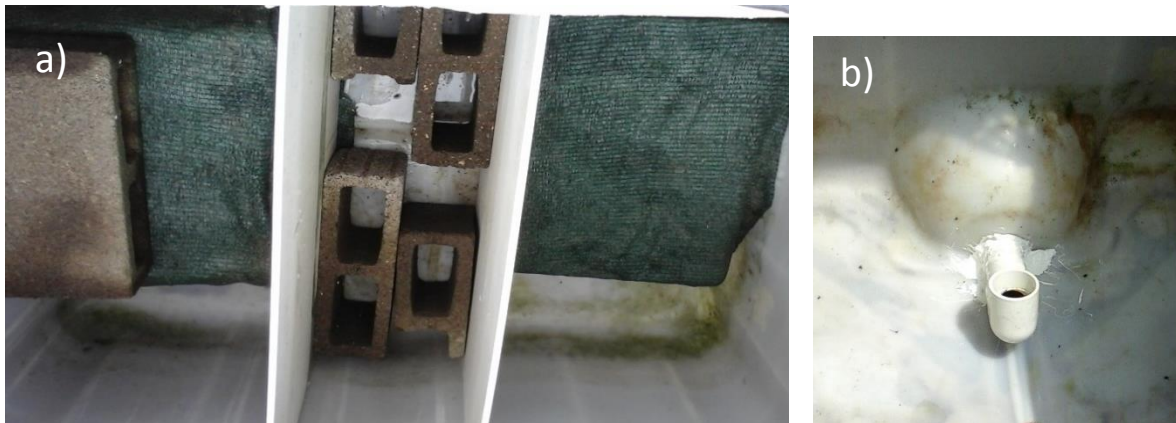
Figura 3-6. Interior del tanque de compensación sin agua: a) ubicación de pantallas y sarán, b) tubería de salida a 15 cm del fondo.
