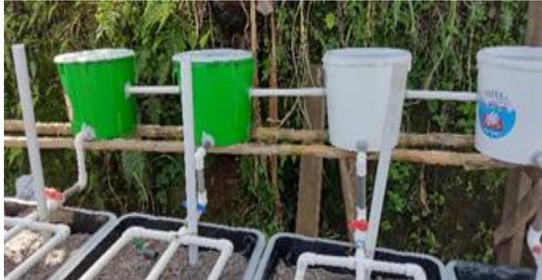
**Figura 14.** Conexión de sistema de abastecimiento de humedales con tubería PVC.
