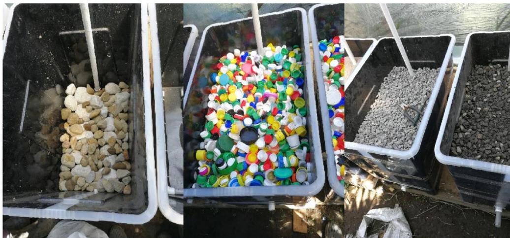
**Figura 13.** Colocación de primeras capas de material filtrante en humedales piloto
