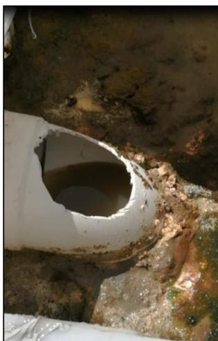
**Figura 22.** Capa de grasa formada en tanques separadores de sólidos.
