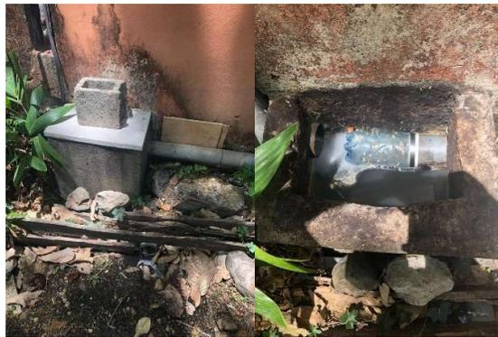
*Figura 12. Trampa de grasa 1 (TG1) ubicada en la parte posterior de la cocina en el HPPS*
