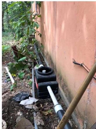
*Figura 13. Trampa de grasa 2 (TG2) ubicada en la parte posterior de la cocina, después de la TG1*
