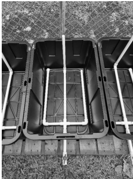
Figura 8. Sistema de drenaje para la extracción de aguas residuales tratadas de los HA.
