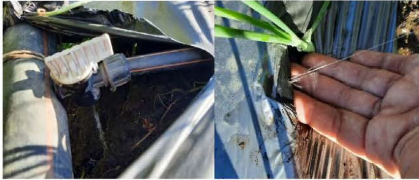
Figura 33. Fugas encontradas en las líneas de riego
