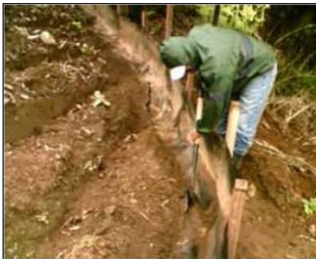
Figura 14. Limpieza de la barrera de geotextil luego de la recolección de sedimento (Prado, 2007).
