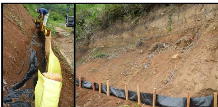
Figura 5.6 Ejemplo de talud D 07 y su proceso erosivo. Fuente. El autor.
