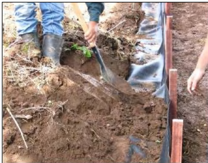
Figura 11. Desgaste a los bordes del surco colindantes con el geotextil (Prado, 2007).
