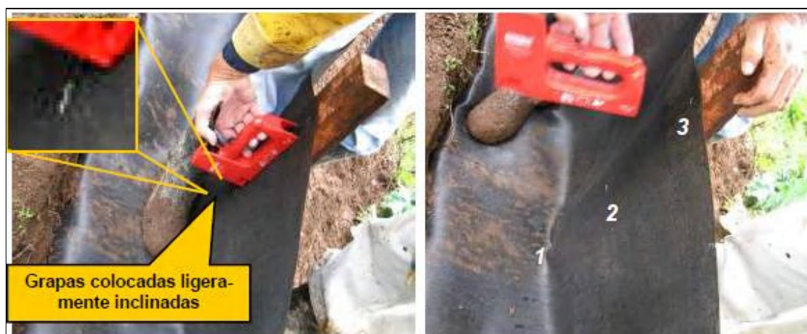
Figura 10. Colocación de las grapas para la fijación del geotextil a las estacas (Prado, 2007).
