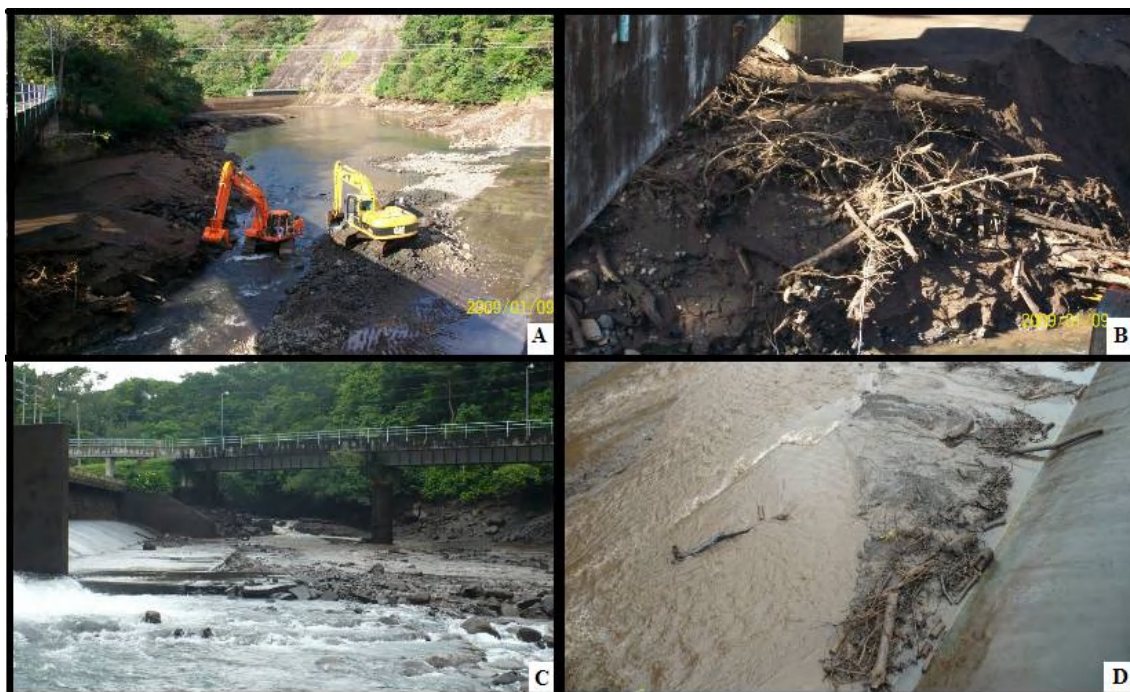
Figura 1.2 A, B) Inspección y limpieza del embalse Santa Rosa, realizado en enero 2009, del cual se extrajo el 90% del material acumulado (7 200 m 3 de lastre grueso) C, D) Monitoreo julio 2009 para ver el estado del mismo. Fuente. Sánchez, K (2009)
